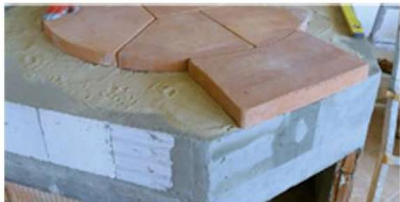
Coibentare i forni per uso professionale utilizzando blocchi di gas beton\* di 20cm ed aumentare di 5cm la coibentazione superiore e laterale.
